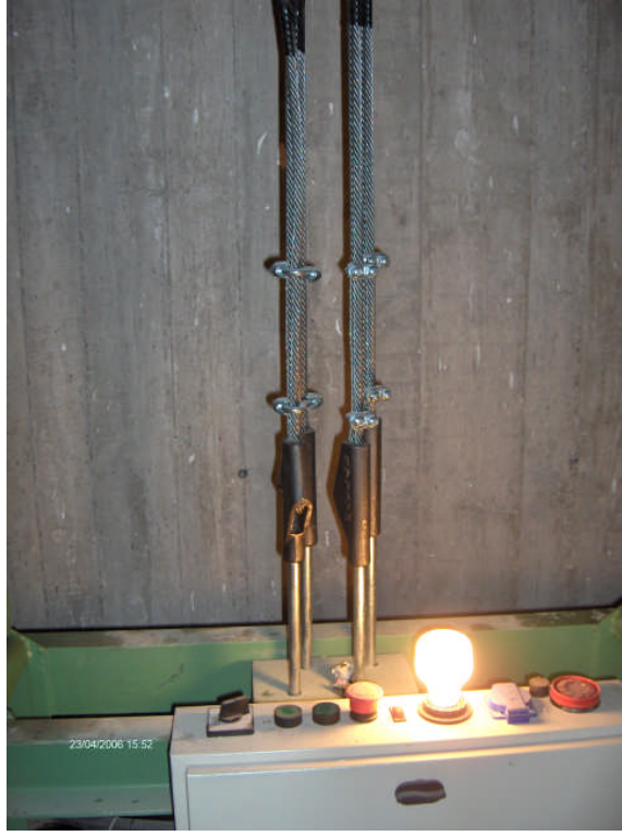
Resim 5.4: Halat şişesi kullanılarak yapılmış kabin halat bağlantısı
