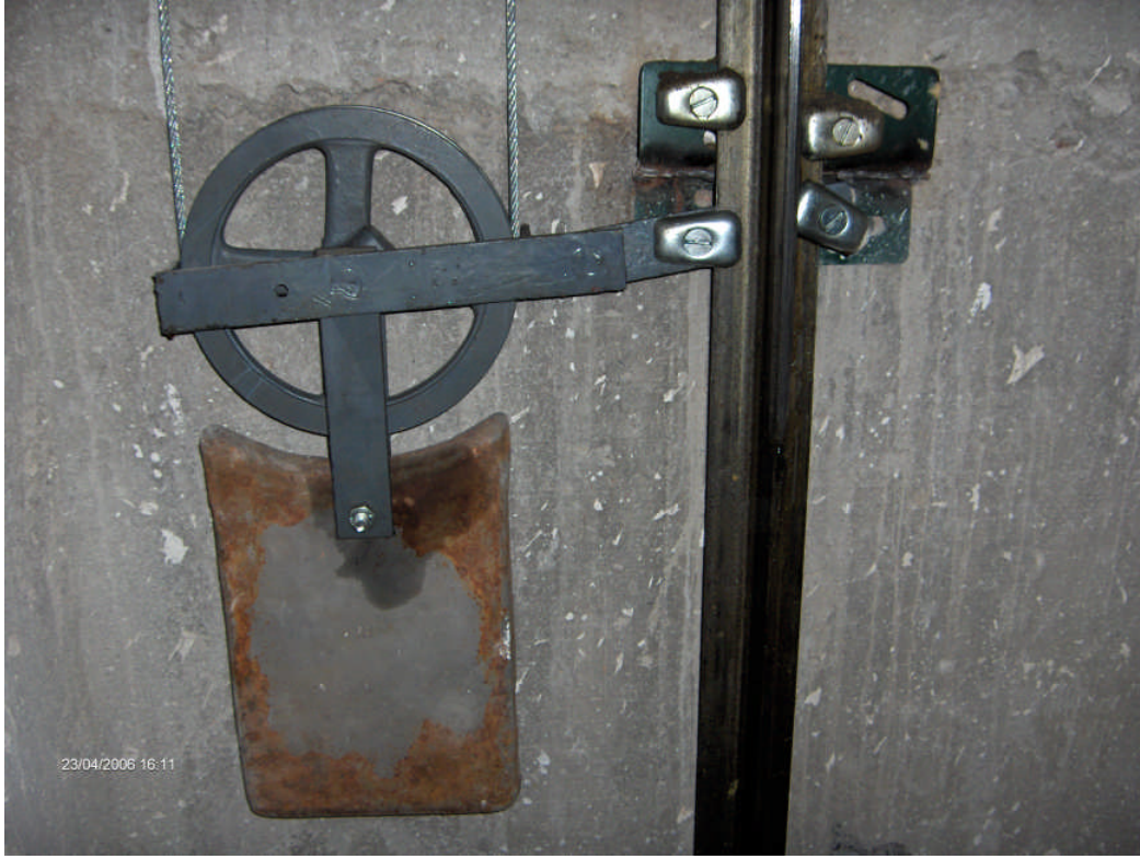
Resim 6.2: Regulator makarası, ağırlığı ve raya bağlantısı
