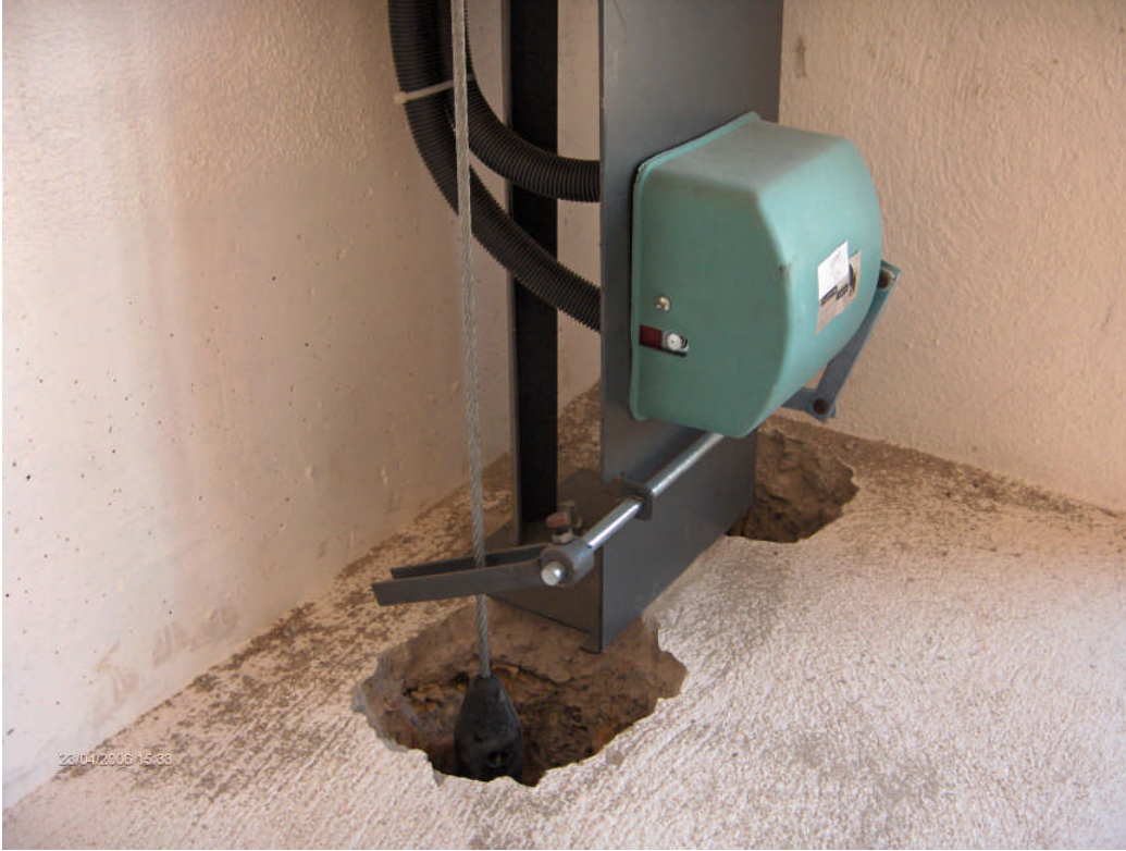
Resim 5.7: Bol şalteri ve regülatör halinde takılı olan plastik takoz
