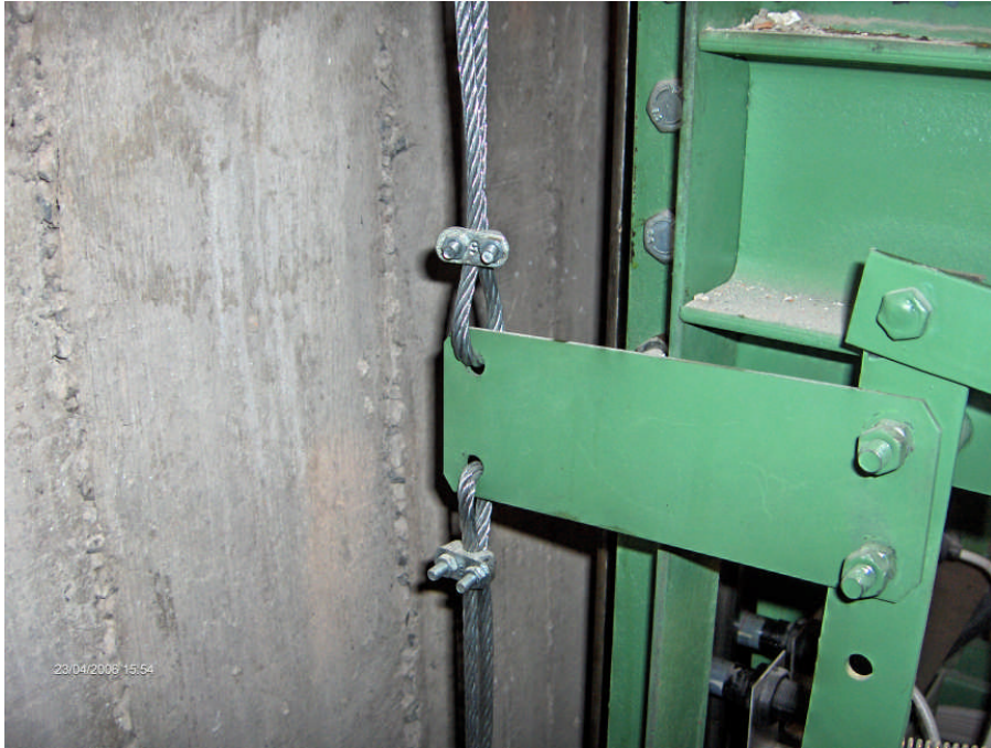
Resim 5.5: Regülatör halatının kabinde üstünün veya altında bulunan fren mekanizmasına bağlantısı
