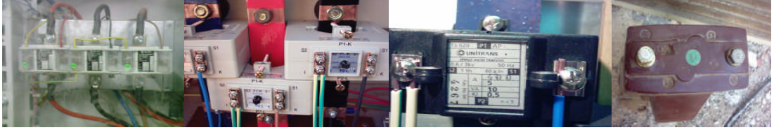
Resim 2.2: AG-OG Akım trafoları bağlantıları
