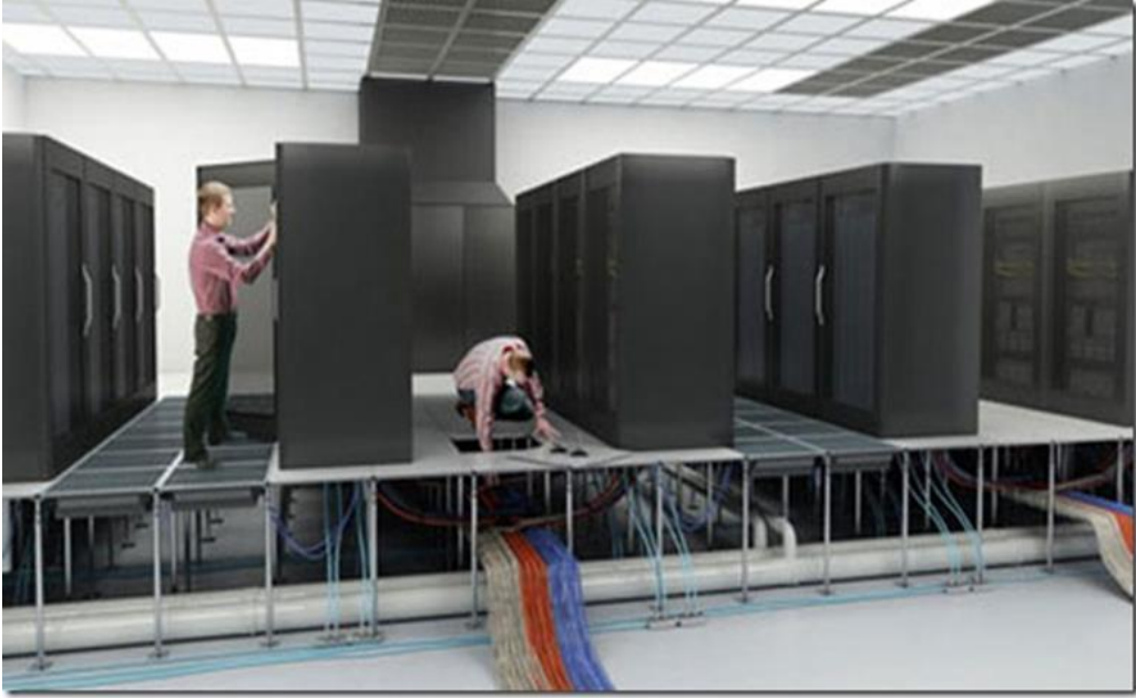
Resim 1.15: Yükseltilmiş zeminin su baskınlarını önlemedeki etkisi
