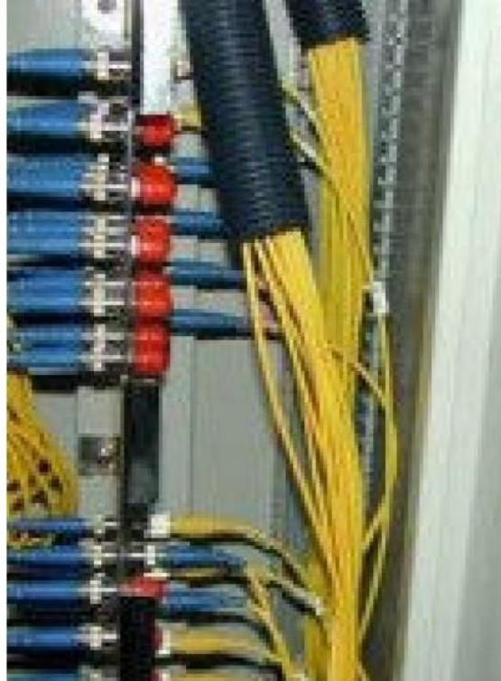
Şekil 3.46: Kaset bağlantısı PIGTAIL
