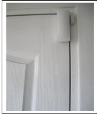
Resim 2.19: Kablolü kapı kontađının kapı ve pencerelere montajı (kapı kapalı – açık )
