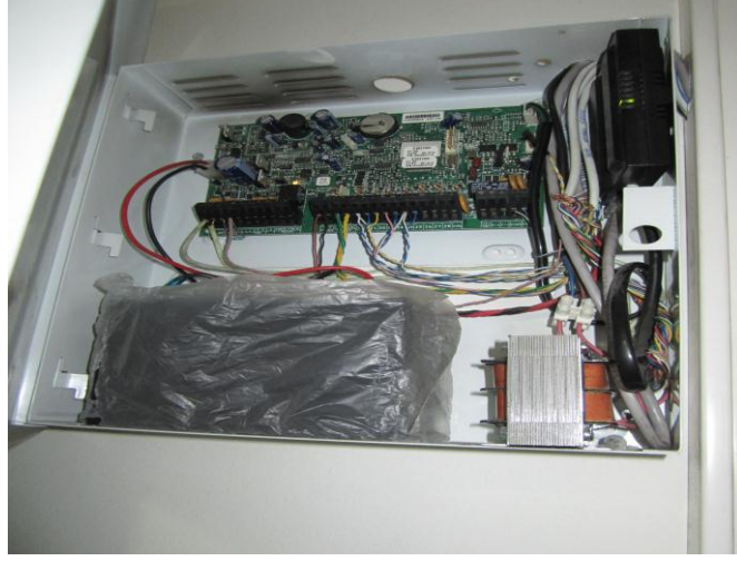
Resim 2.3: Kutu içine montajlı alarm paneli
