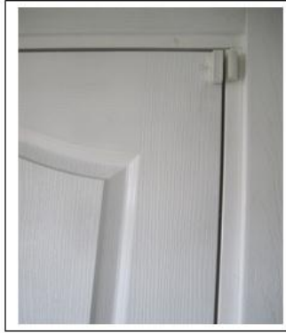
Resim 2.19: Kablolü kapı kontađının kapı ve pencerelere montajı (kapı kapalı – açık )
