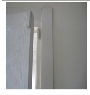
Resim 2.19: Kablolü kapı kontađının kapı ve pencerelere montajı (kapı kapalı – açık )
