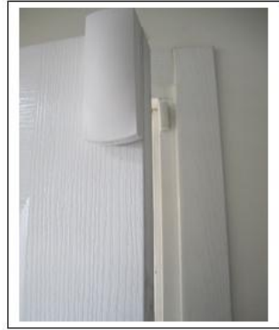
Resim 2.19: Kablolü kapı kontađının kapı ve pencerelere montajı (kapı kapalı – açık )
