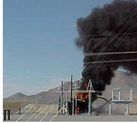
Resim 1.4: Yangın koruma eşikli şalter ve bir trafo yangını
