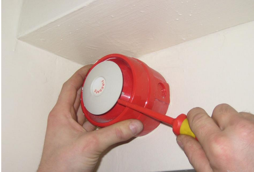
Resim 3.6: Siren montajı
