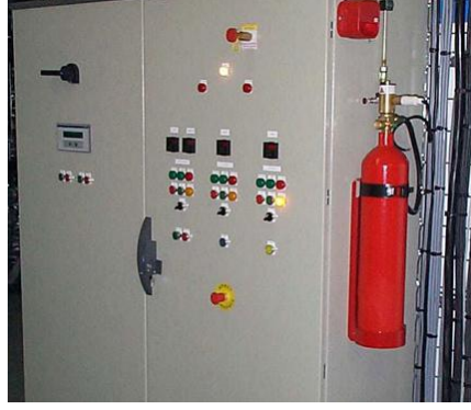
Resim 6.6: Otomatik söndürme sistemi ile korunan elektrik kumanda ve dağıtım odası
