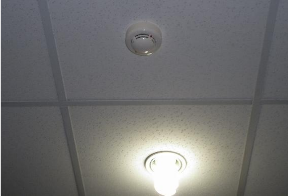
Resim 2.14: Dedektör aydınlatma armatürlerine mesafe ayarı
