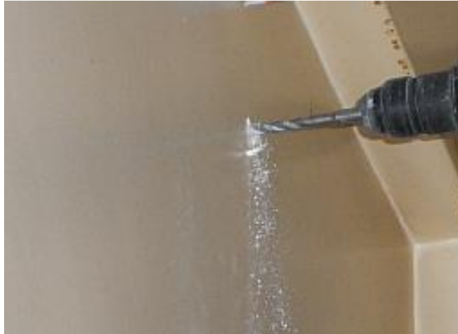
Resim 1.21:Panel montaj deliklerini matkap ile delme işlemi
