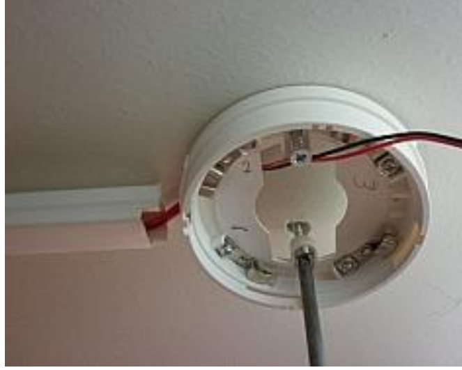
Resim 1.22: Dedektör tabanının yerleştirilmesi
