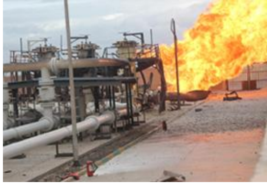
Resim 1.9: Doğal gaz tesisinde meydana gelen bir patlama ve yangın
