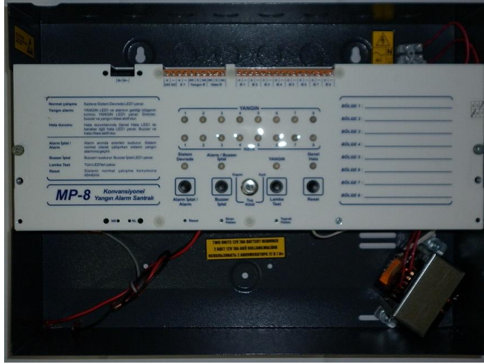
Resim 1.20:Panel kapağının açılması
