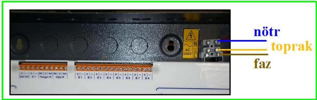
Resim 1.17: Panel besleme kablo klemens bağlantıları
