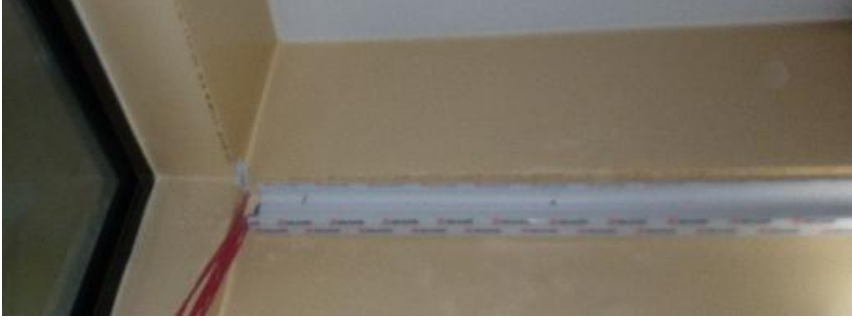
Resim 7.3: Sistem için gerekiyorsa kanal döşeme işleminin yapılması
