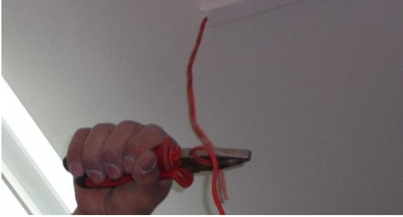
Şekil 7.4: İletkenleri döşeme işleminin gerçekleştirilmesi
