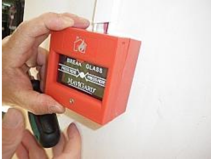
Resim 1.23: Yangın ihbar butonu yerleşimi
