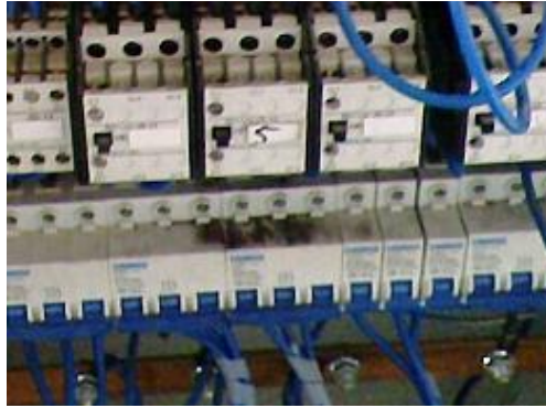
Resim 1.7: Gevşek bağlantı sebebi ile kontakları yanan sigorta
