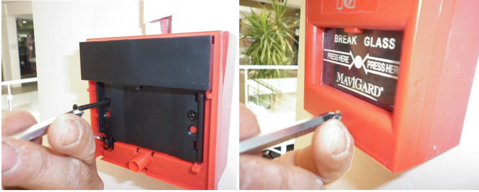
Resim 4.7: Buton montajı
