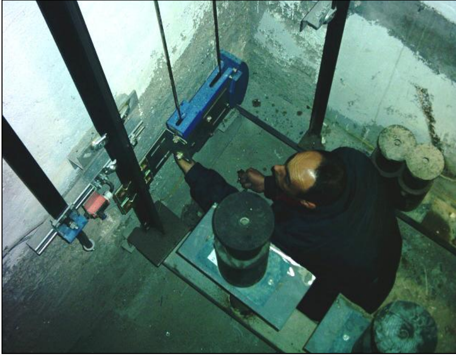
Resim 1.15: Solda “son kat bilgi şalteri”, ortada kuyu dibi hız regülatörü halat gevşeme kontağı, sağda kabin ve karşı ağırlık tamponları
