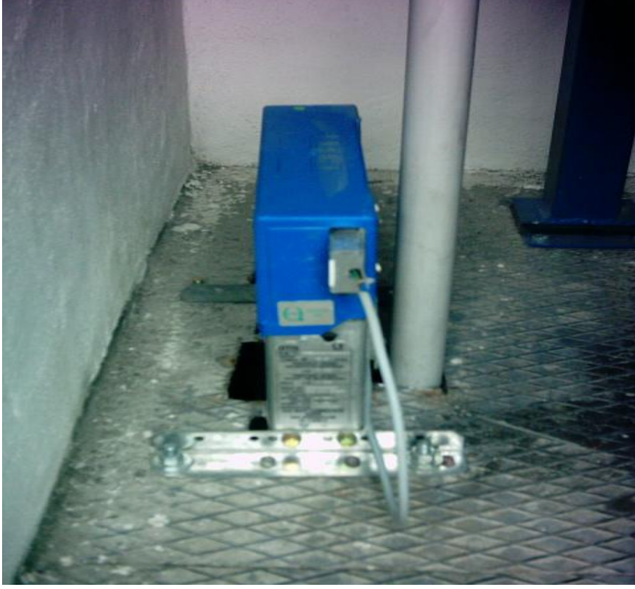
Resim 1.14: Hız regülatörü ve kontak (makine dairesi)
