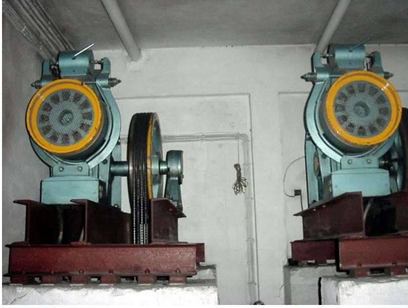
Resim 6.1: Çift pabuçlu fren tertibatı olan makine-motor grupları
