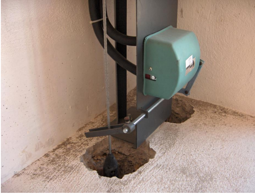
Resim 4.4: Enerjiyi kesmeye yarayan bol şalteri ve halat füzesi
