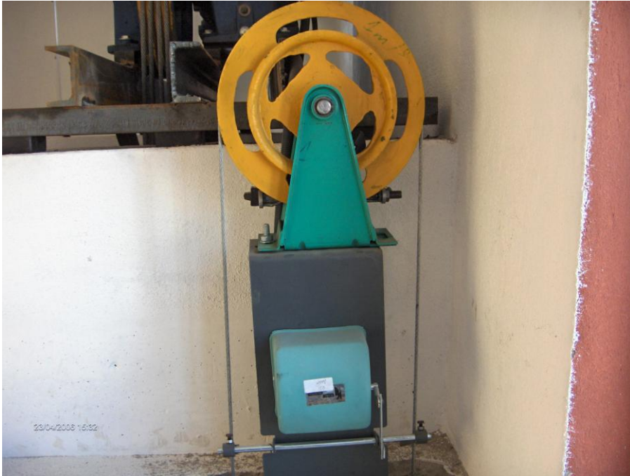
Resim 4.3: Hız regülatörü ve enerjiyi kesmeye yarayan bol şalteri
