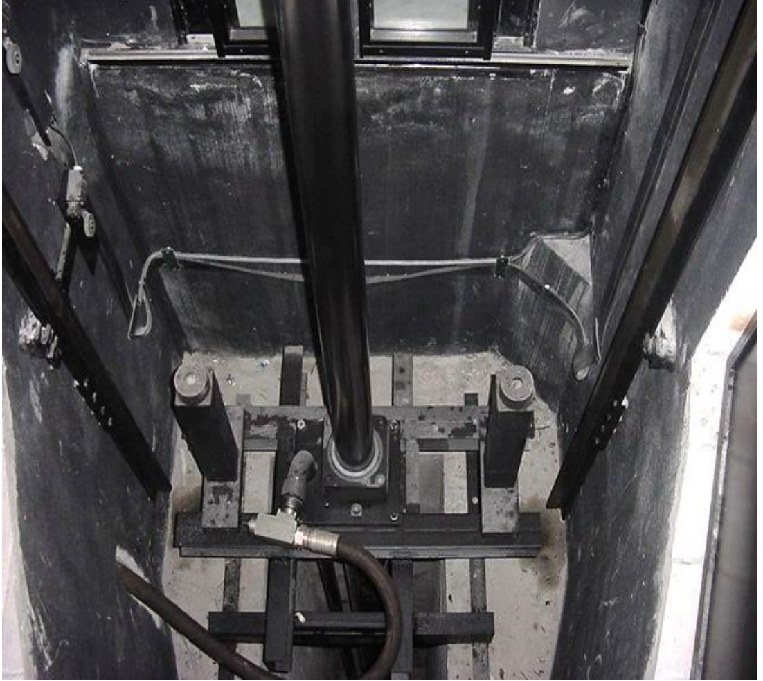
Resim 1.13: Merkezden tahrikli hidrolik asansörün kuyu dibi görüntüsü
