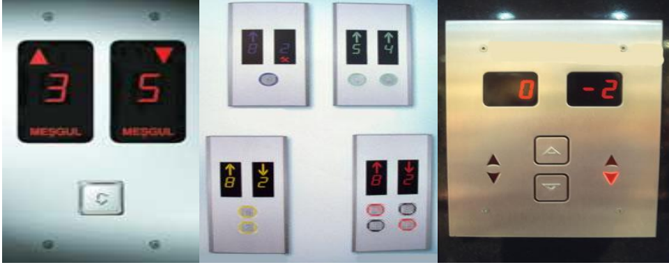
Resim 2.6: Grup kumanda katta kasetleri (gösterge ve butonlar)
