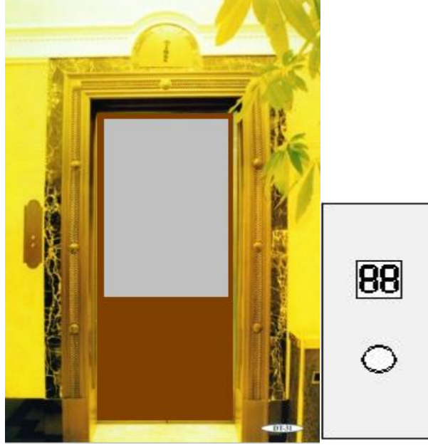
Resim 1.2: Basit kumanda ve kat göstergeli tam otomatik kapılı asansör
