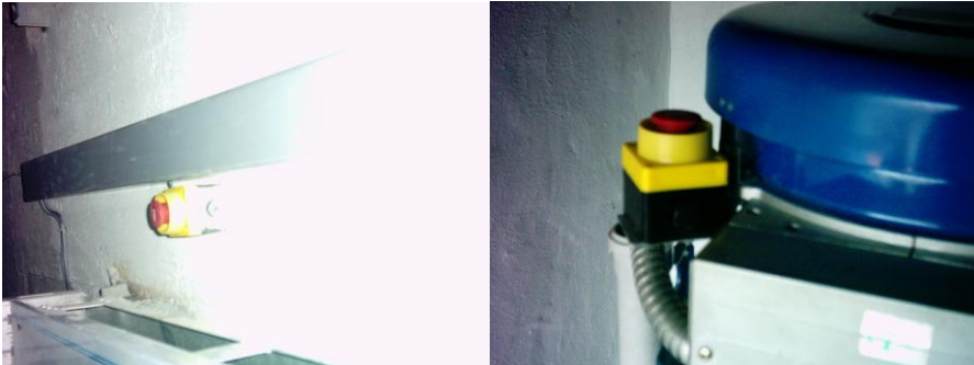
Resim 3.17: Revizyon şalterleri (kuyu içi, makine dairesi)
