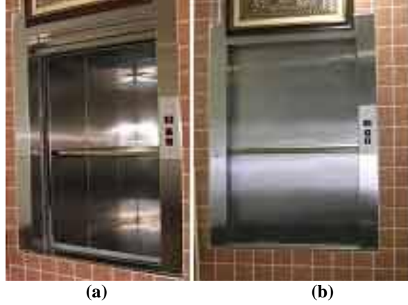
Resim 1.12: Servis asansörde (a) Elle açılan düşey kapı (b) Otomatik açılan düşey kapı
