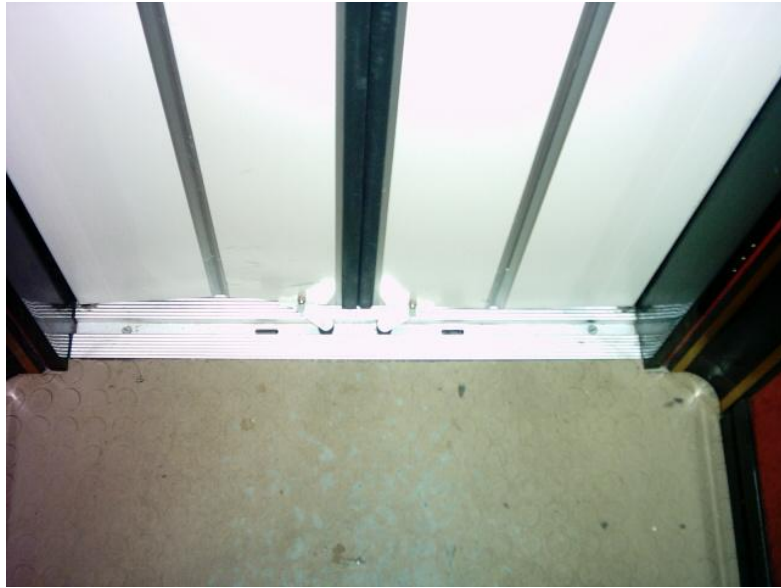
Resim 1.15: İki kanatlı merkezden açılan katlanır kapıların alt rayı
